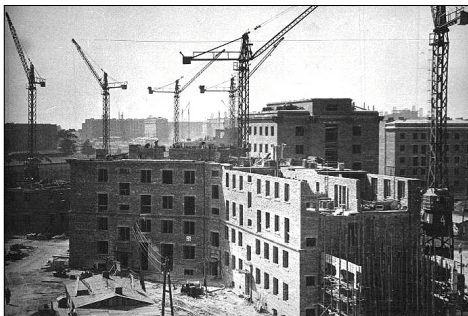
Żurawie dyktują tempo budowy
