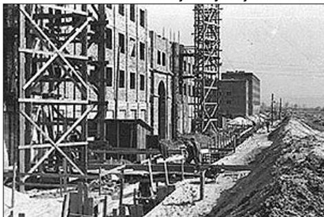
Osiedle C-1 (Teatralne) w budowie.
