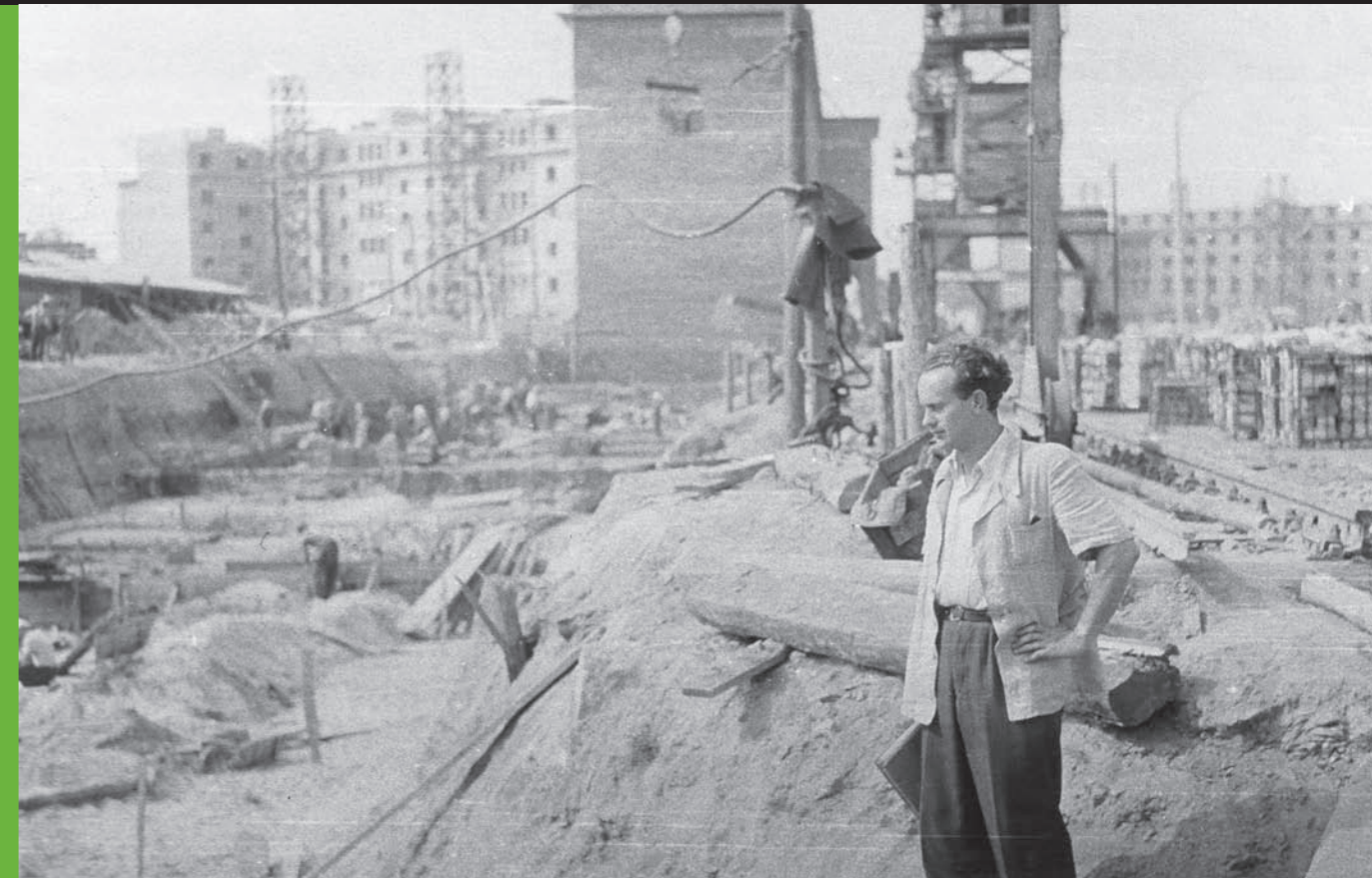
Inspektor nadzoru budowlanego na budowie Centrum „A”
